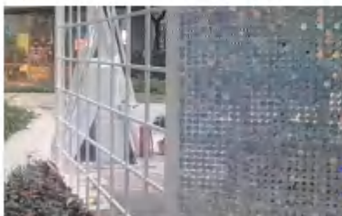
5000*6000挂墙风动片装置 (60*60方通骨架固定在墙上，骨架上扣30*30风动片，造价约60元/平)
