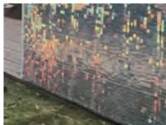
5000*6000挂墙风动片装置 (60*60方通骨架固定在墙上，骨架上扣30*30风动片，造价约60元/平)
