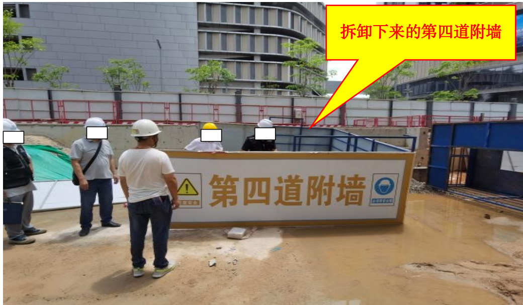
图 4 运至地面的第四道附着操作平台（部分）
