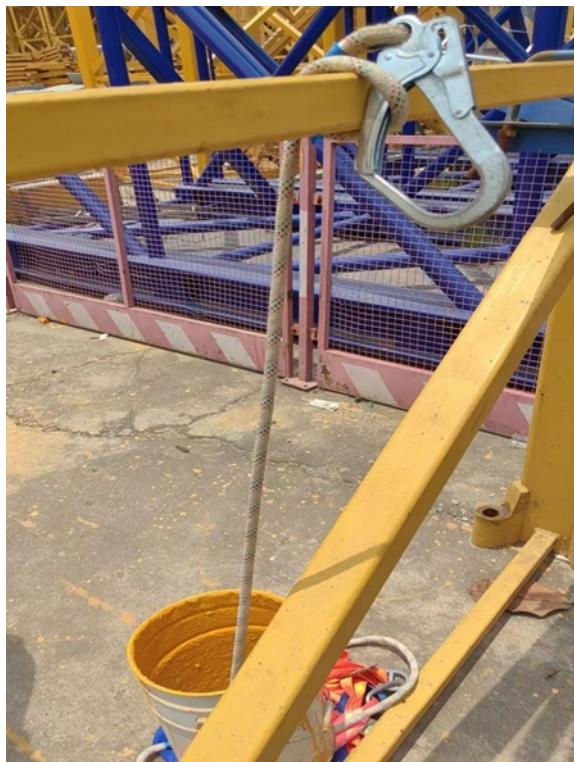
图 15 王某华（死者）作业时安全带系挂模拟情况
