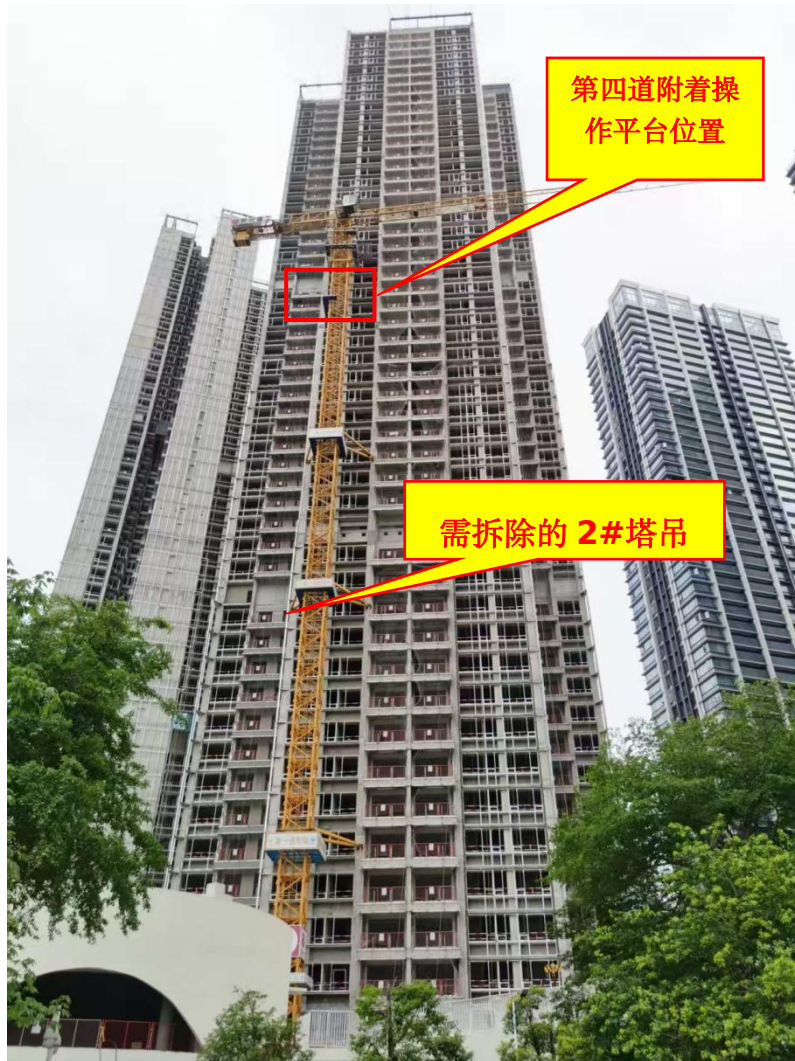
图 2 需拆除的 2#塔吊
