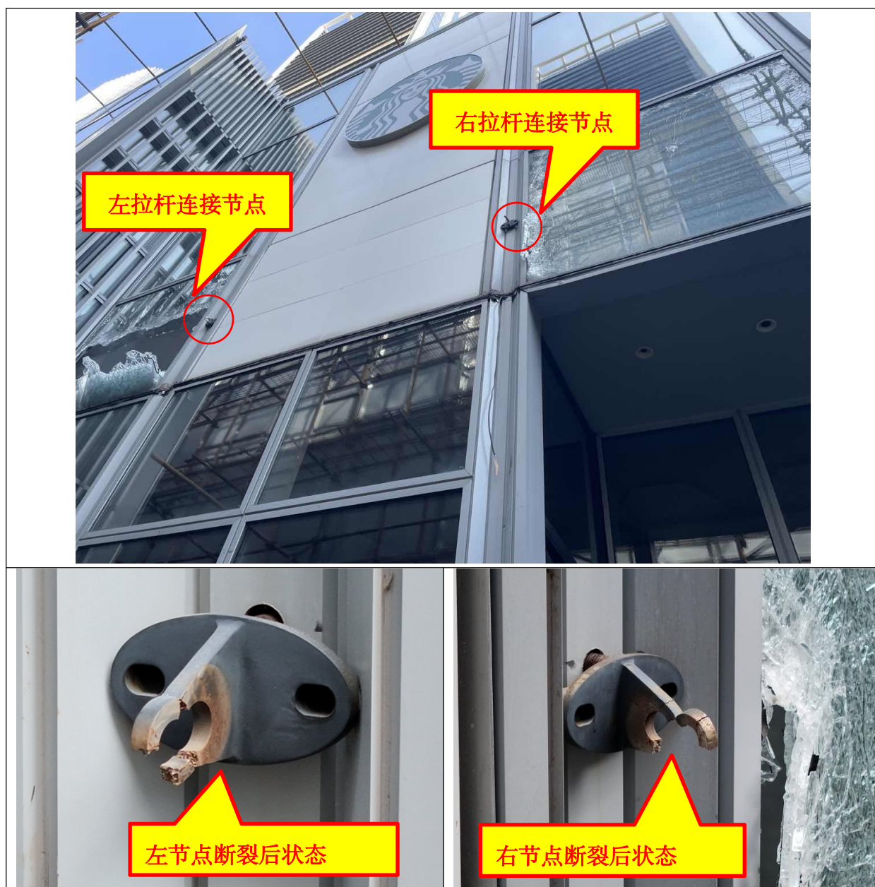
图 10 幕墙框架处拉杆连接节点状态
