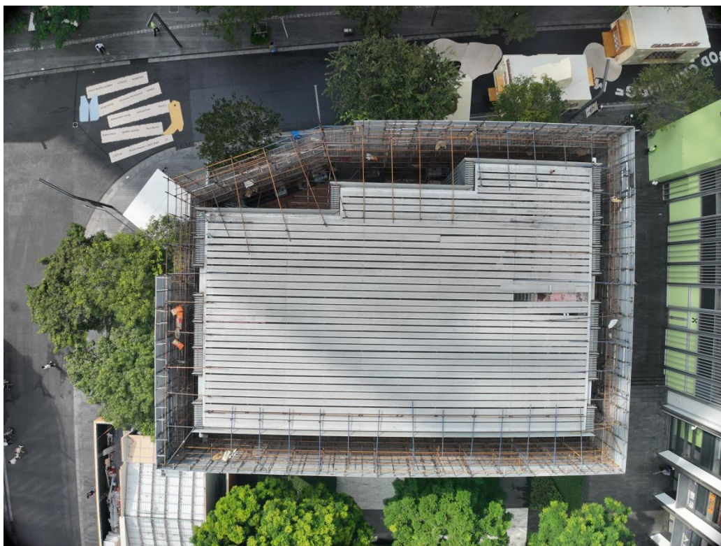
图1 项目现场概况
