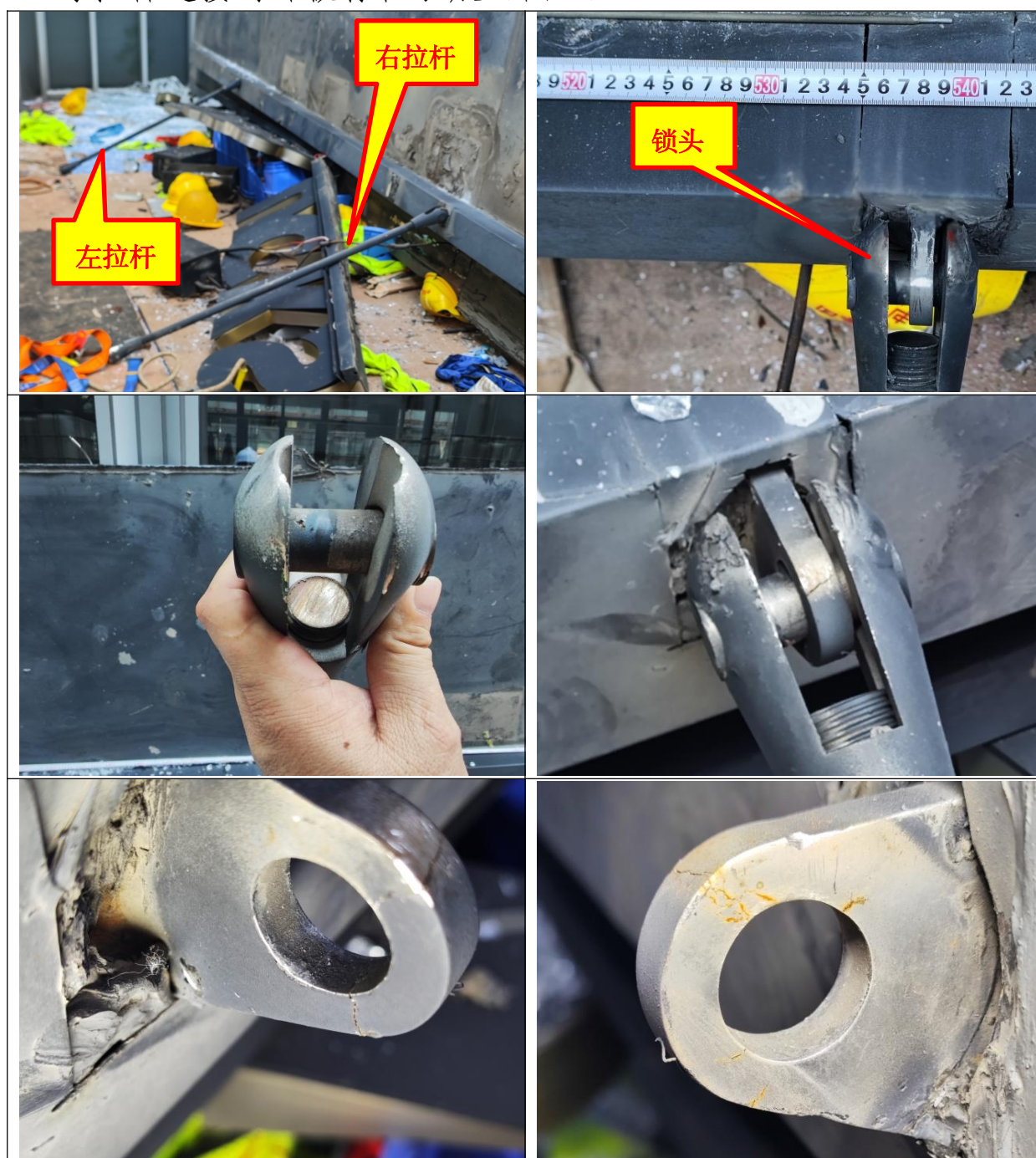
图8 商铺雨篷吊挂装置状态
