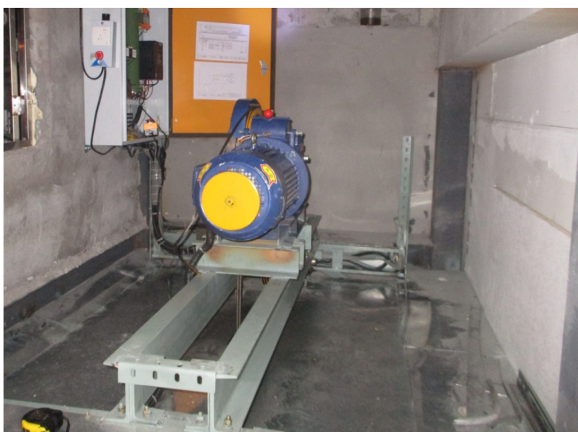
图 4 机房空间的布置（底部封闭）
