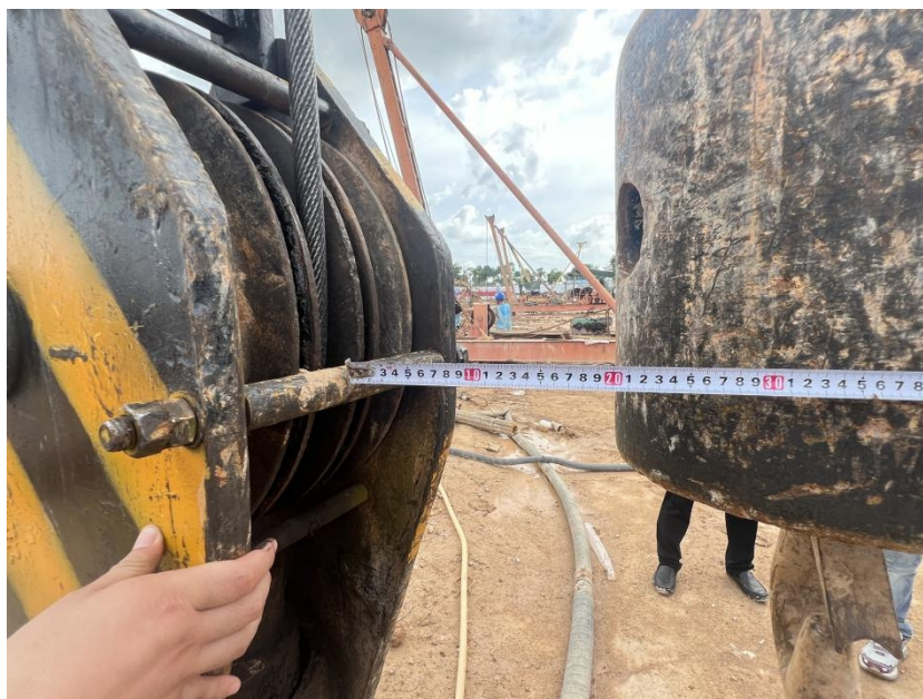
图 8 涉事履带吊主副吊钩间距
