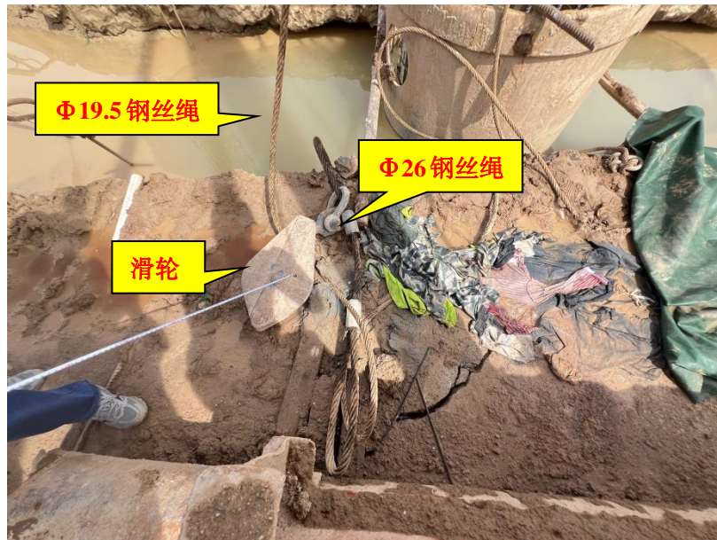
图 4 地面滑轮及钢丝绳参数
